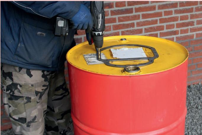
Platzieren Sie den Dichtring der Frontplatte in der Mitte des Fasses und bohren Sie alle Löcher.
